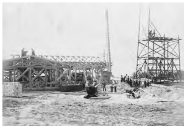
Budowa zajezdni Chocianowice, ok. 1900 r. (ze zbiorów Biblioteki Uniwersytetu Łódzkiego)
