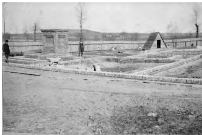
Zajezdnia Chocianowice, widok fundamentów i podstawy komina, ok. 1900 r. (ze zbiorów Biblioteki Uniwersytetu Łódzkiego)
