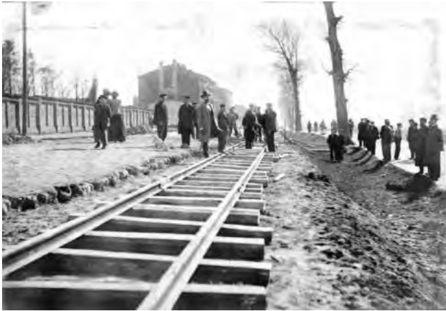
Budowa torowiska kolejki dojazdowej Łódź – Pabianice, 1901/1902 r. (ze zbiorów Biblioteki Uniwersytetu Łódzkiego)
