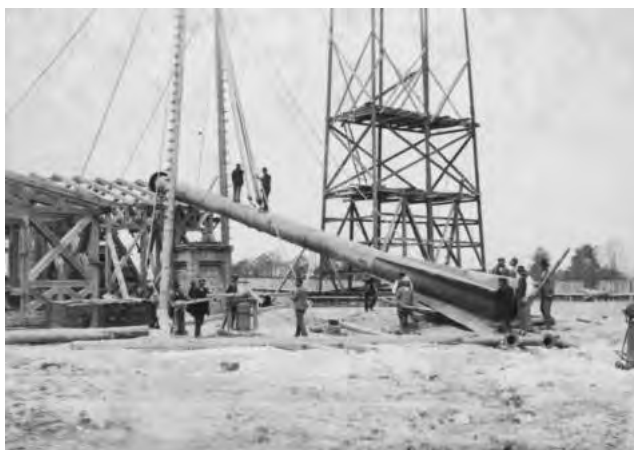
Chocianowice, montaż komina, ok. 1900 r. (ze zbiorów Biblioteki Uniwersytetu Łódzkiego)
