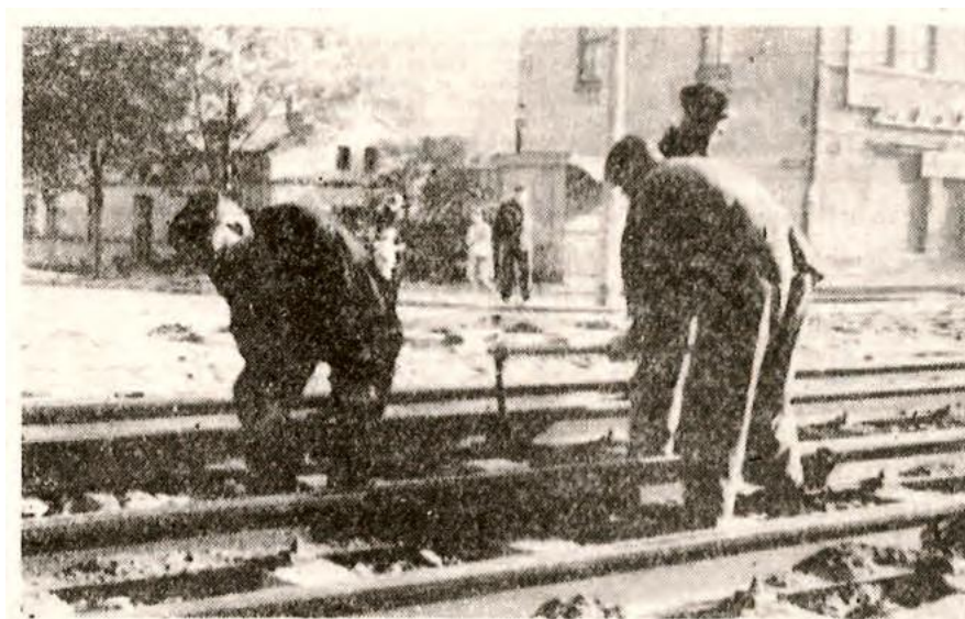
Roboty przy układaniu linii tramwajowej dobiegły końca. Ekipy MPK szybko wywiązały się ze swego trudnego zadania. Foto: F. MIKLIANIEC
