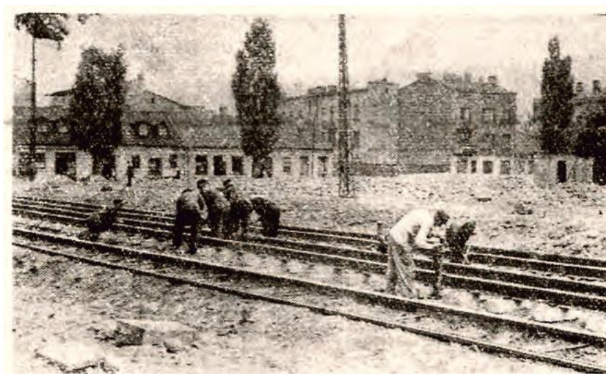
Pracownicy MPK rozpoczęli zakładanie nowych szyn tramwajowych przy placu Obrońców Stalingradu Foto: S. C.
