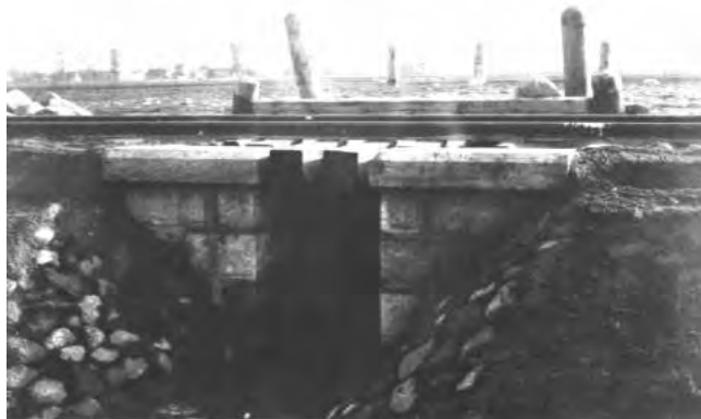
Mostek kamienny wybudowany na trasie Łódź – Pabianice, ok. 1901 r. (ze zbiorów Biblioteki Uniwersytetu Łódzkiego)
