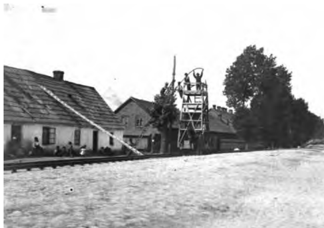
Trasa Łódź – Pabianice, montaż słupów sieci trakcyjnej, ok. 1900 r. (ze zbiorów Biblioteki Uniwersytetu Łódzkiego)
