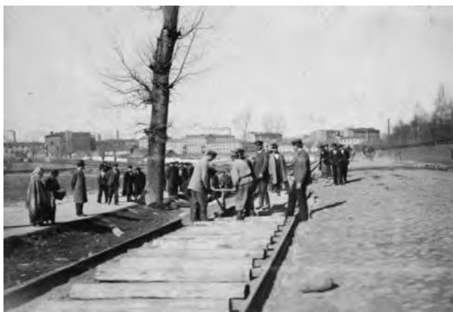
Pierwsze prace przy układaniu torów kolejki dojazdowej do Pabianic, w tle widok zabudowań Górnego Rynku w Łodzi, kwiecień 1900 r. (ze zbiorów Biblioteki Uniwersytetu Łódzkiego)
