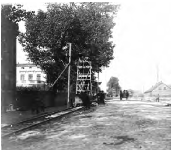
Trasa Łódź – Pabianice, montaż sieci trakcyjnej, w głębi widok Pałacu Königa przy ulicy Pabianickiej (ze zbiorów Biblioteki Uniwersytetu Łódzkiego)
