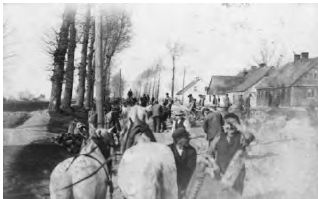
Budowa torowiska kolejki dojazdowej Łódź – Pabianice, ok. 1900 r. (ze zbiorów Biblioteki Uniwersytetu Łódzkiego)
