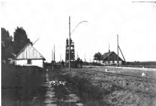
Trasa Łódź – Pabianice, montaż słupów sieci trakcyjnej, ok. 1900 r. (ze zbiorów Biblioteki Uniwersytetu Łódzkiego)
