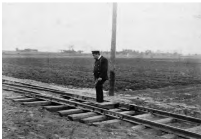
Tory tramwajowe typu Vignoles na trasie Łódź – Pabianice, 1900/1901 r. (ze zbiorów Biblioteki Uniwersytetu Łódzkiego)
